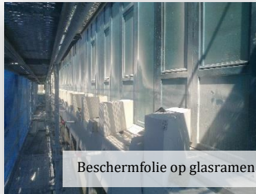
Beschermfolie aanbrengen
